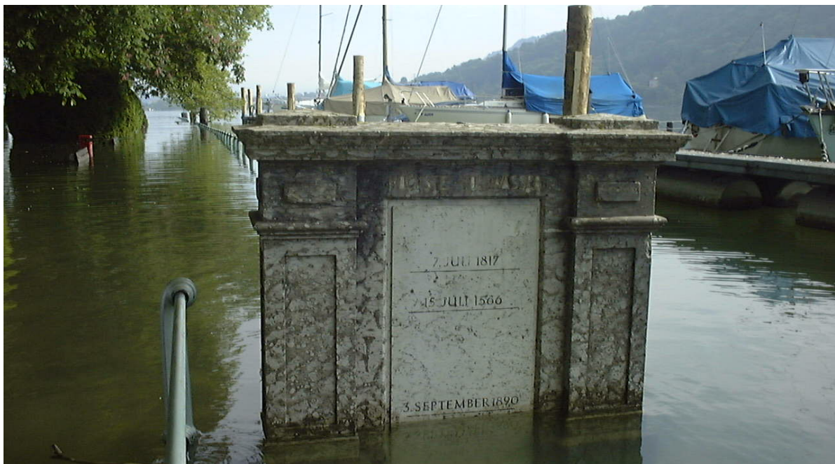
Abb. 1: Historische Hochwassermarken in Bregenz am Obersee. Die Aufnahme erfolgte während des Hochwassers 1999. Durch Setzungen des Steines ist der Wasserstand des Jahres 1999 im Vergleich zu den früheren Wasserständen etwa 5 cm zu hoch. Foto und Information zur Setzung: AVL R
